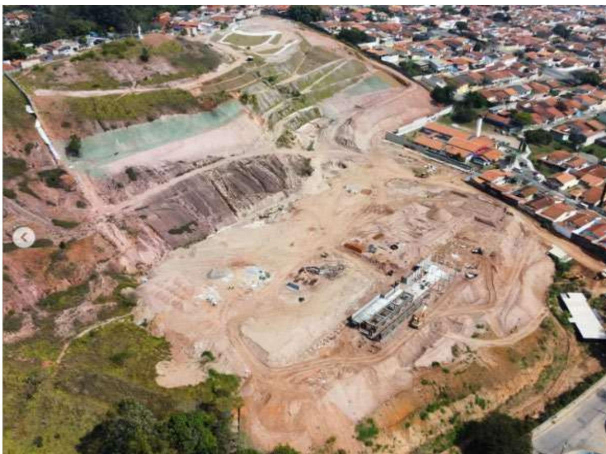
Vista aérea da construção do estádio
